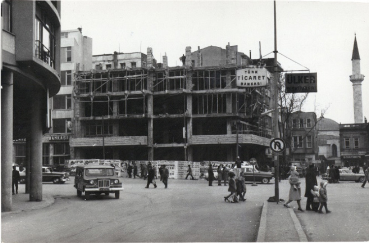
Şekil 6: Kadıköy'deki Yapı ve Kredi Bankası binası inşaata- 15-02-1971 [36]
