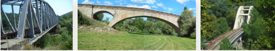
Şekil 4: Zonguldak-Irmak demiryolu köprüleri (Ağustos 2015)
