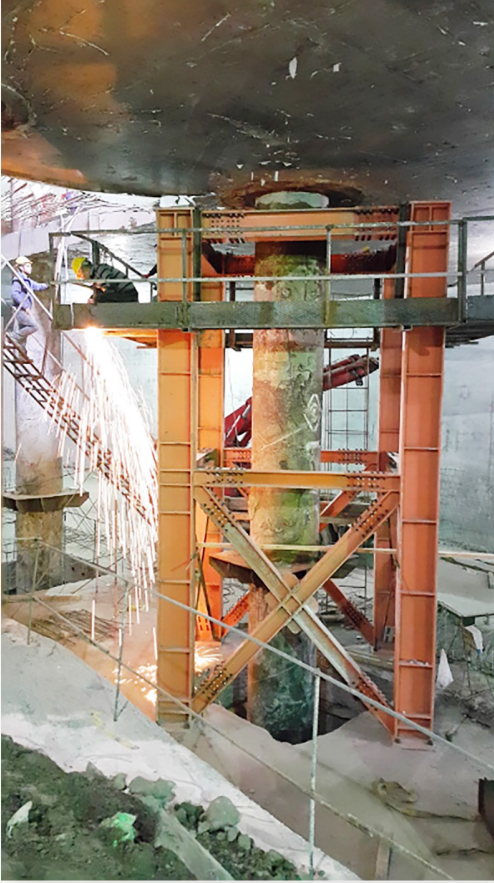
Şekil 11: Kazık Kolon Kesimi
