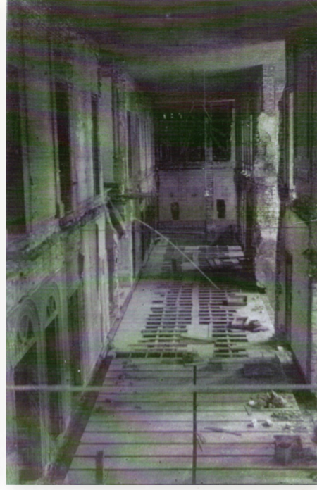
Şekil-9: 1937 uygulaması sırasında zemin kat döşemesi değişimi, Prof. Sait Kuran Arşivi [40].
