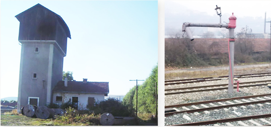
Şekil 3: Zonguldak-Irmak demiryoluna ait su teşkilat yapısı ve donatısı (Ağustos 2017)
