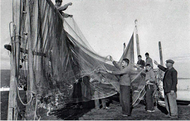
Şekil-12: Hasanoğlan Köy Enstitüsü'nde yığma taş ve tuğla sistem yapının öğrenciler tarafından inşaatı, Ankara Mimarlar Odası
