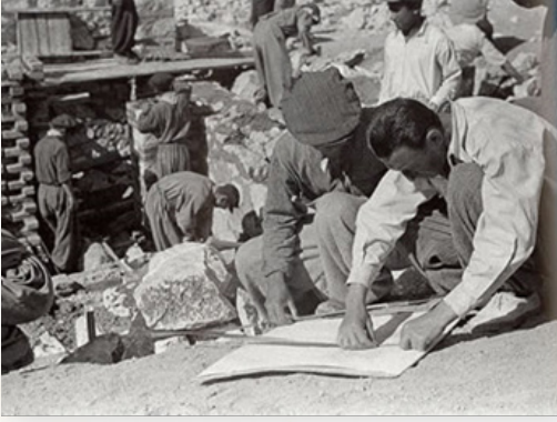
Şekil-17: Hasanoğlan Köy Enstitüsü şantiyesinde eğitimci ve öğrenciler, Mimarlar Odası Ankara Şubesi
