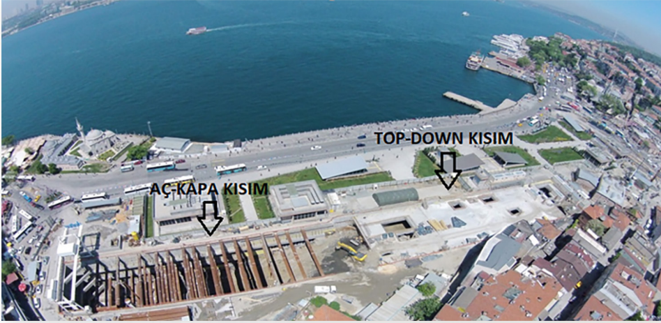
Şekil 4: Üsküdar İstasyonu İnşaat Durumu Havadan Görünümü
